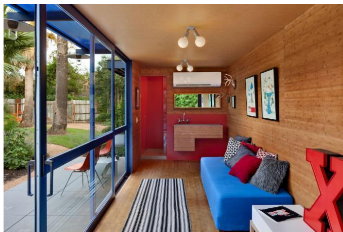
Figura 16 – Sala/Quarto revestidos com compensado de bambu
