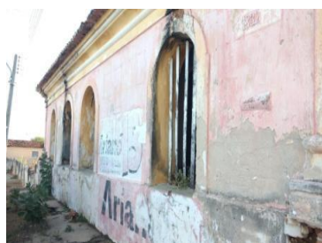
Figura 13 – Janelas em arco pleno
