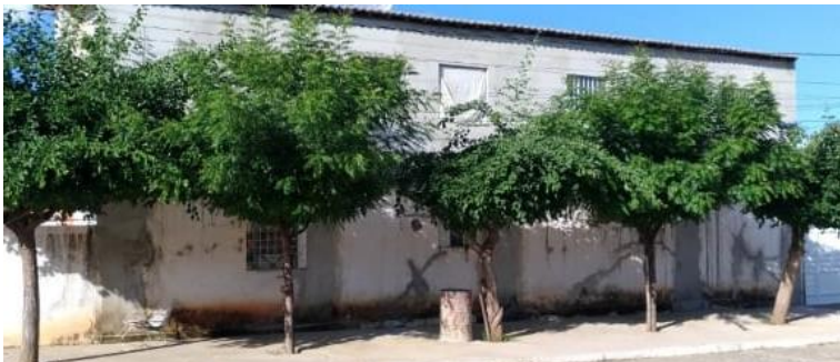
Figura 10 – Fachada na cor amarela
