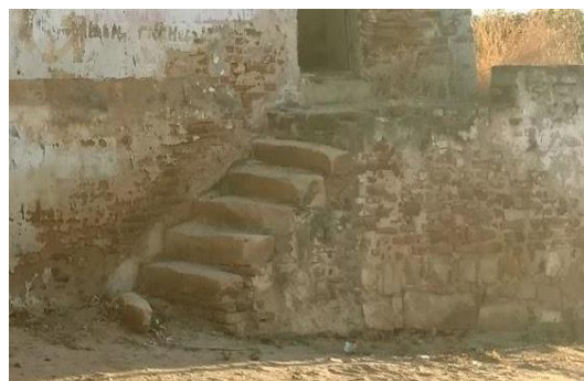
Figura 16 – Escada de acesso à cozinha Fonte: Acervo Pessoal (2017).
