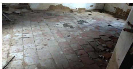
Figura 8 – Piso em ladrilhos de barro Fonte: Acervo Pessoal (2017).
