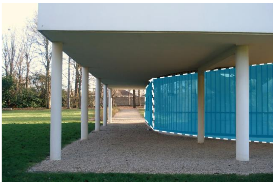
Figura 32 – Elementos semicirculares existentes no pavimento térreo do edifício
