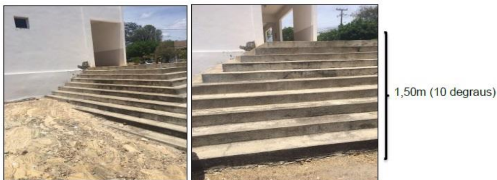
Figura 10 – Escadas de Acesso ao Bloco de Salas de Aula
