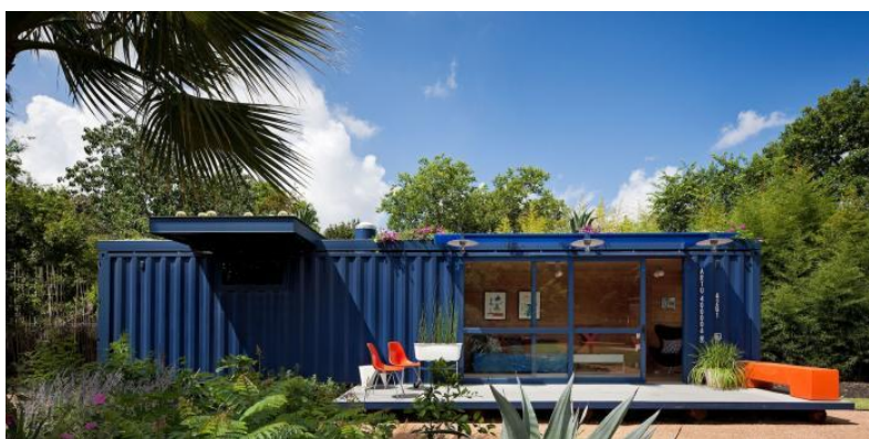
Figura 14 – Fachada principal da Guest House
