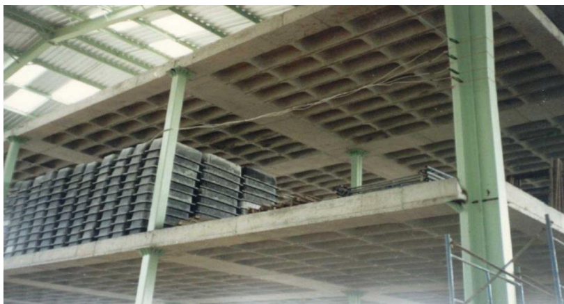
Figura 2 – Estrutura – Concreto apoiado por aço Fonte: https://www.flickr.com .
