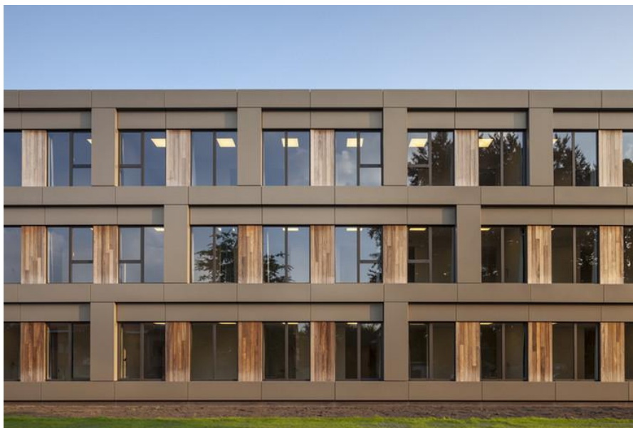
Figura 14 – Materiais e esquadrias da fachada
