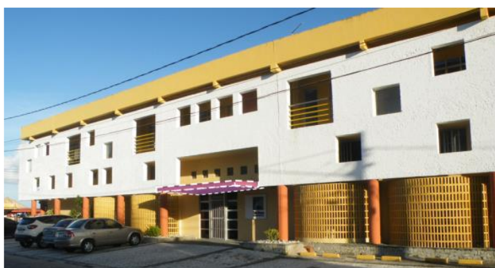
Figura 14 – Marquise que marca a entrada principal do Edifício Cabo Branco Residence.
