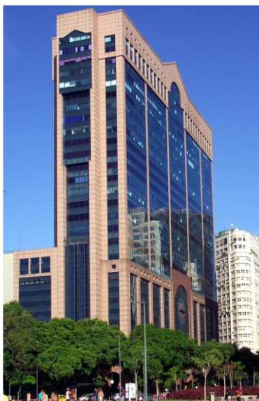
Figura 9 – Edifício Rio Branco, Rio de Janeiro/RJ
