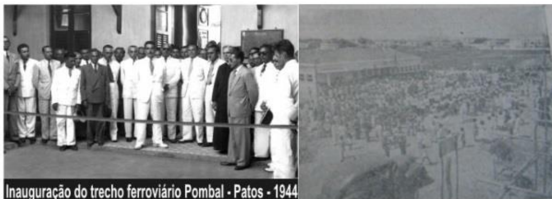
Figura 10 – Inauguração da Estação Ferroviária em Patos/PB
