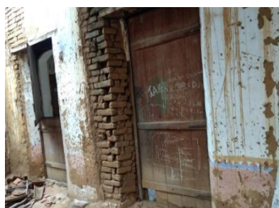
Figura 6 – Paredes em tijolos de barro e portas e janelas em madeira Fonte: Acervo Pessoal (2017).
