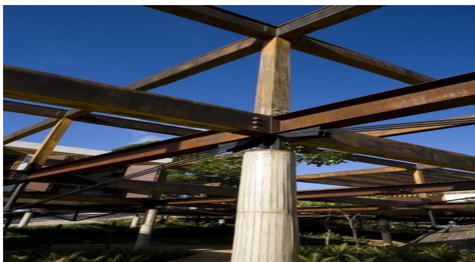
Figura 1 – Estrutura – Concreto e Aço Fonte: http://www.metallica.com.br/casa-grelha .
