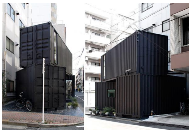
Figura 6 – Residência Tomokazu – Tóquio 2016
