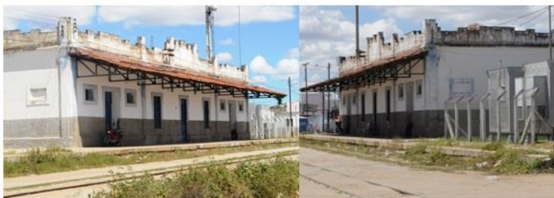
Figura 11 – Estação Ferroviária (2018) em Patos/PB
