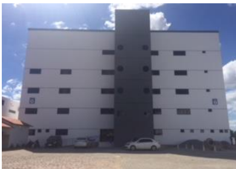
Figura 3 – Fachada Frontal do Bloco G – Arquitetura e Urbanismo
