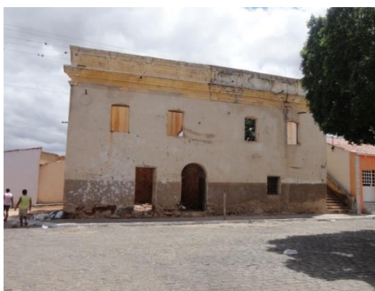
Figura 2 – Situação da Cadeia Velha do município de Teixeira-PB antes da intervenção Fonte: Memorial descritivo e especificações da Reforma da antiga Casa de Câmara e Cadeia de Teixeira-PB (2016).
