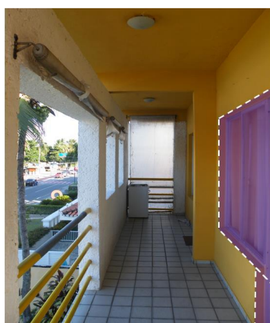
Figura 22 – Esquadria de Metal e Vidro existente na edificação Fonte: Emmanuel Brito Von Szilágyi (2018). Imagem alterada em 2018.
