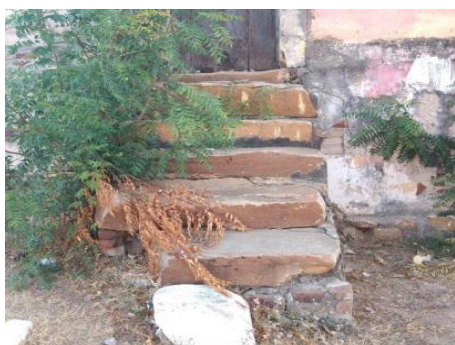
Figura 15 – Escada acesso principal Fonte: Acervo Pessoal (2017).
