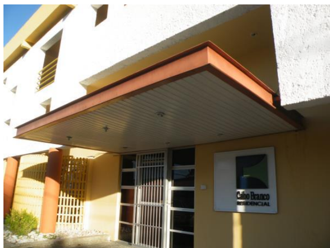
Figura 15 – Detalhe da Marquise existente no Cabo Branco Residence
