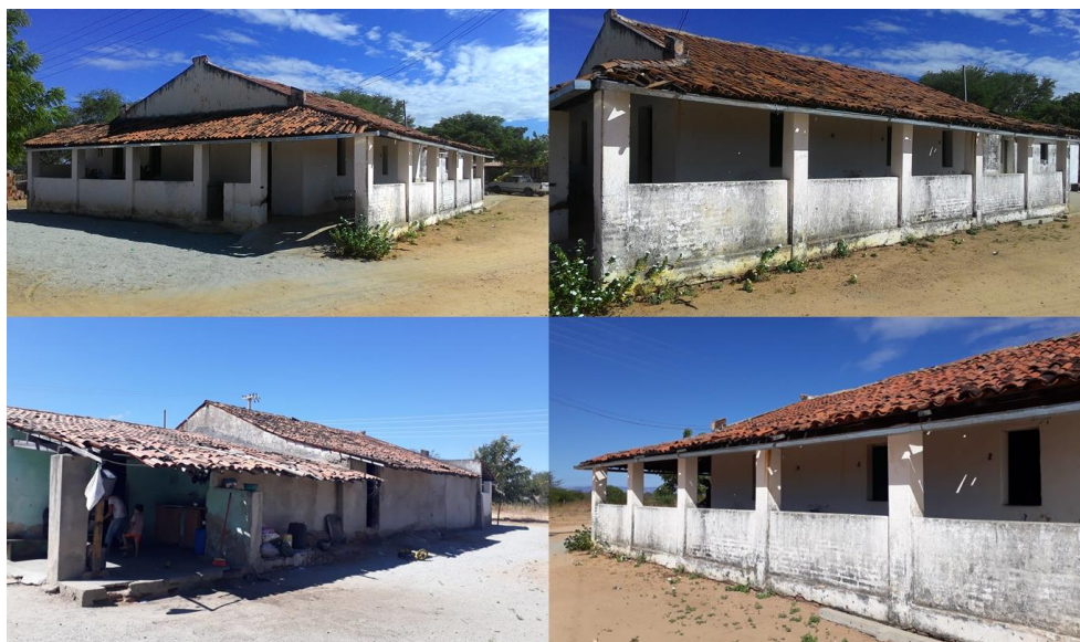
Figura 5 – Vistas das fachadas da residência objeto de estudo Fonte: Autores (2018).
