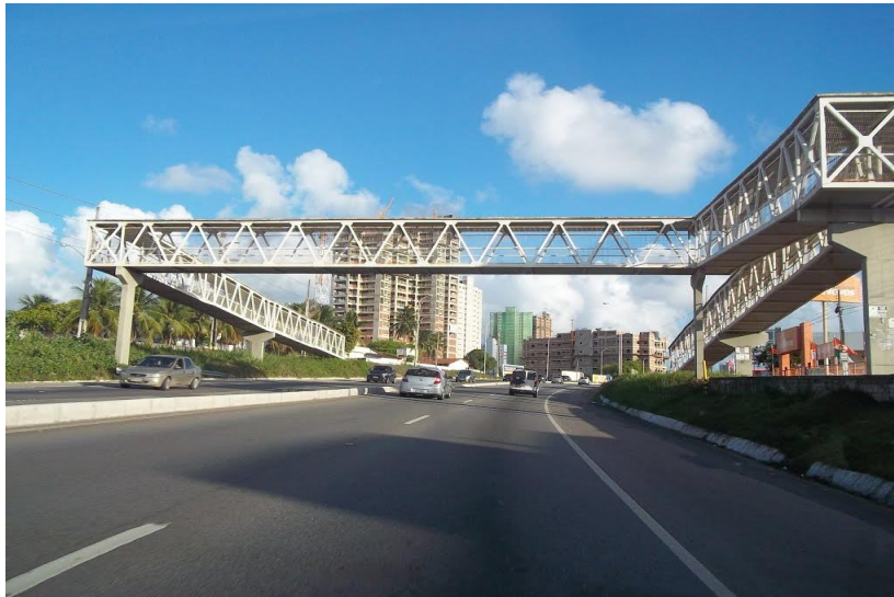
Figura 4 – Passarela na BR-230, João Pessoa-PB
