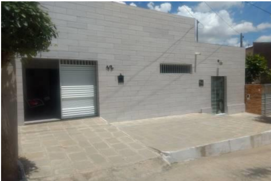
Figura 9 – Calçadas do bairro Fonte: Arquivo Pessoal.
